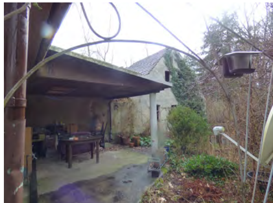
Fotos 4: Straßenansicht Freisitz am Garagennebengebäude und Blick auf ruiniertes Nebengebäude (Giebelseite)
