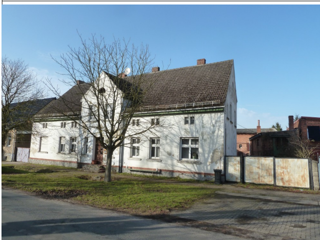
Abbildung: Ansicht von Schönhagener Dorfstraße (Südseite)
